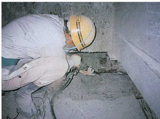
沓座コンクリートはつり作業状況
