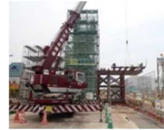
施工段階毎の記録実施
