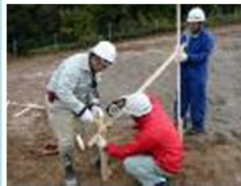
設計図に合わせ丁 張り設置、施工
