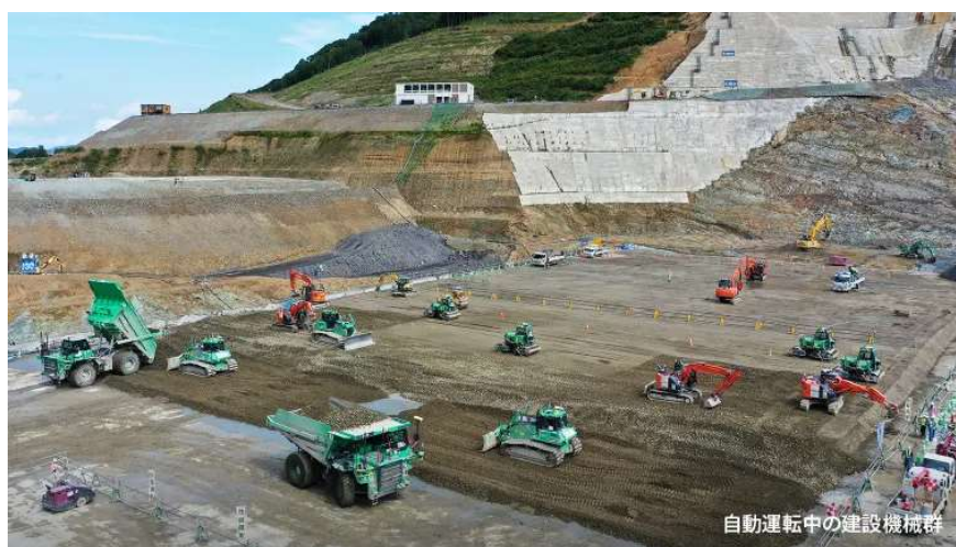
建設機械の自動運転による施工システム(鹿島建設株式会社HPより)
