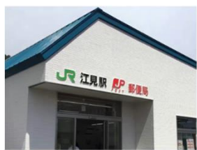
駅舎の 新改築・移設
