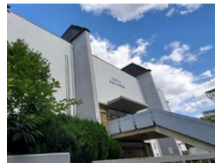
大原市立東瀬川体育館ほか (4施設一棟)
