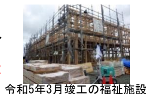
令和5年3月竣工の福祉施設
