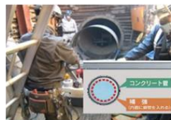
例：管路の耐震補強
