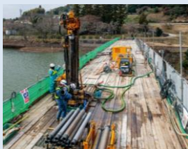
堤体PSアンカー施工状況
