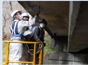
現地点検の実施状況
