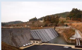
工事完了全景写真 (景観を保持)
