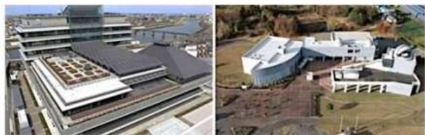
トライアル・サウンディングの対象になる市役所庁舎（左）と科学センターの全景 （出所：阿南市）
