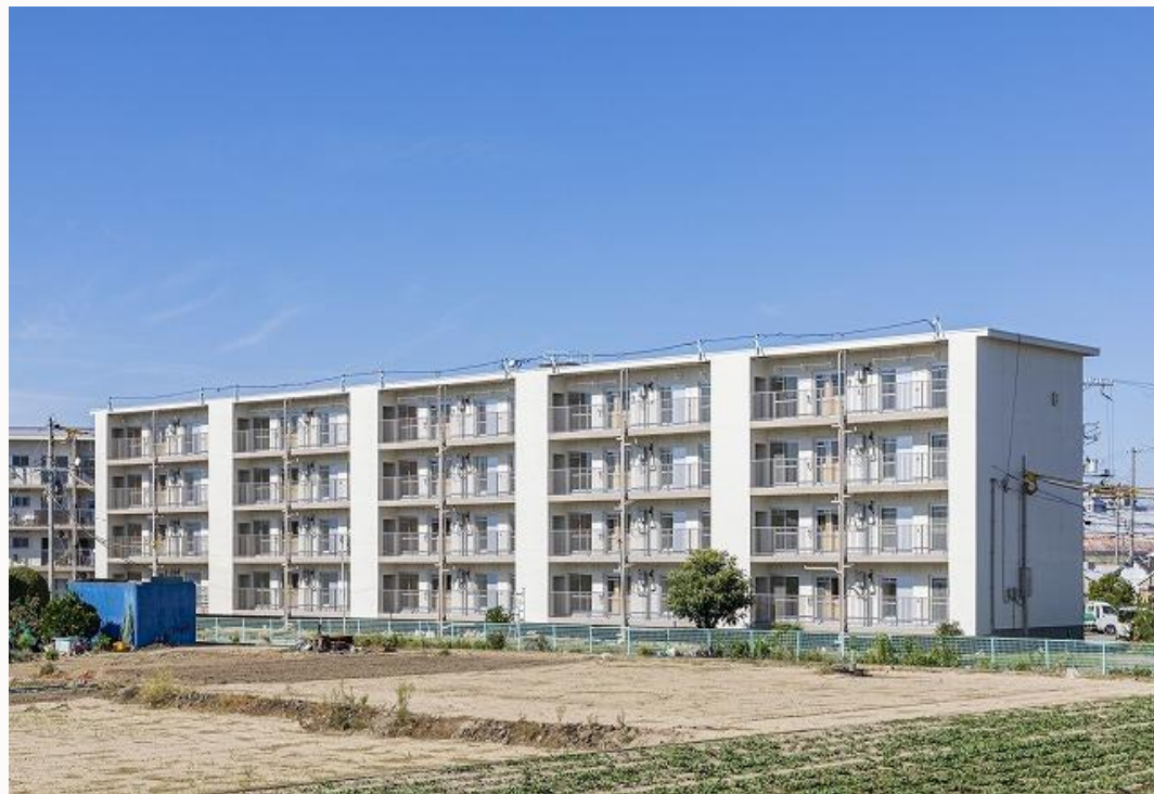
外壁補修塗装・ベランダ手摺を取替え新設
