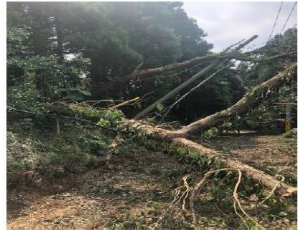
倒木による電柱倒壊（四街道市）
