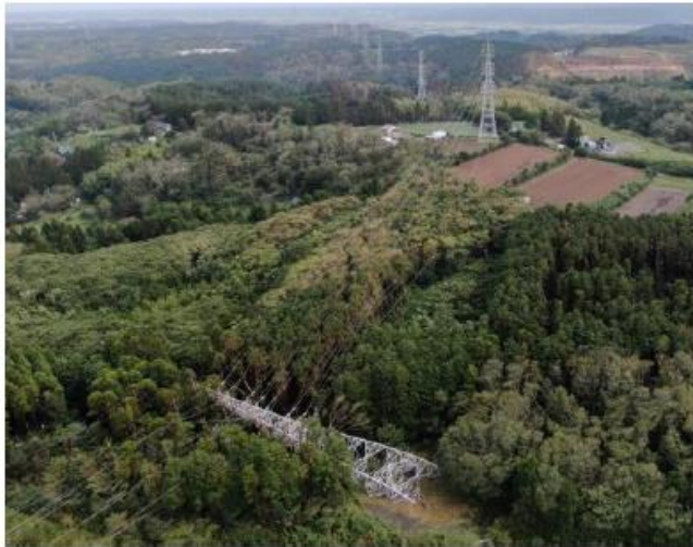
鉄塔設備の倒壊（君津市）
