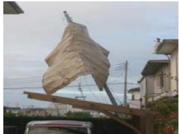
飛来物による電柱倒壊（東金市）
