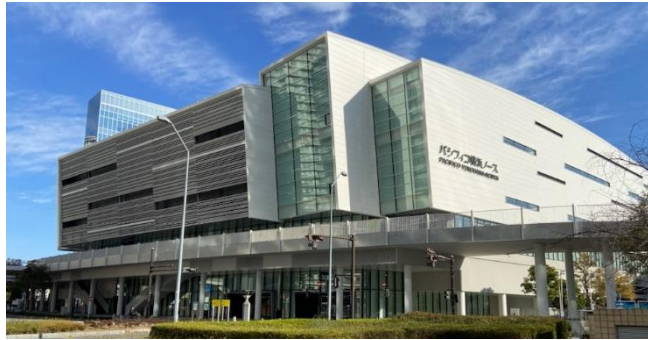
横浜みなとみらい国際コンベンションセンター外観
