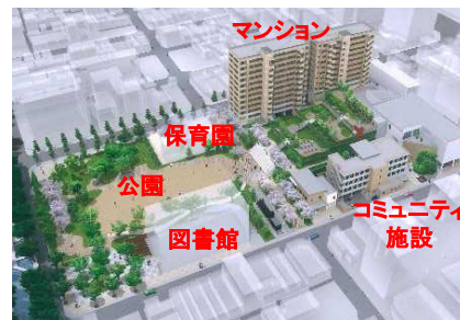
岡山市：出石小学校跡地整備事業
