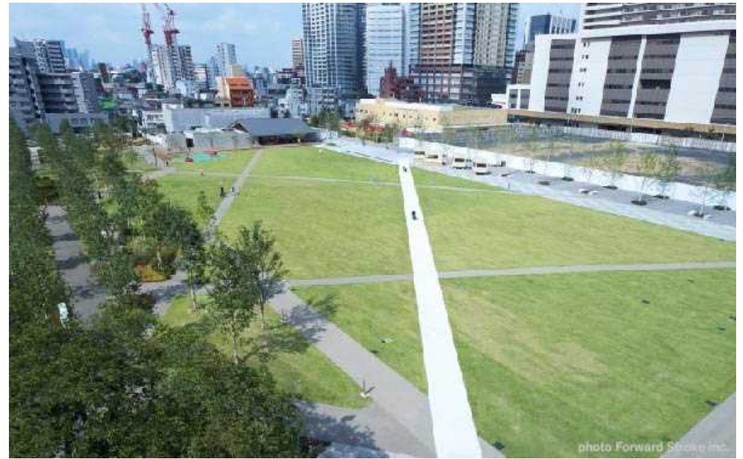
芝生広場は災害時にヘリポートになるほか、耐震性貯水槽や非常用発電施設など地域防災拠点として必要な施設を備えている
