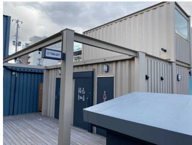
特定公園施設として事業者が整備し、 市が買取した公衆用トイレ
