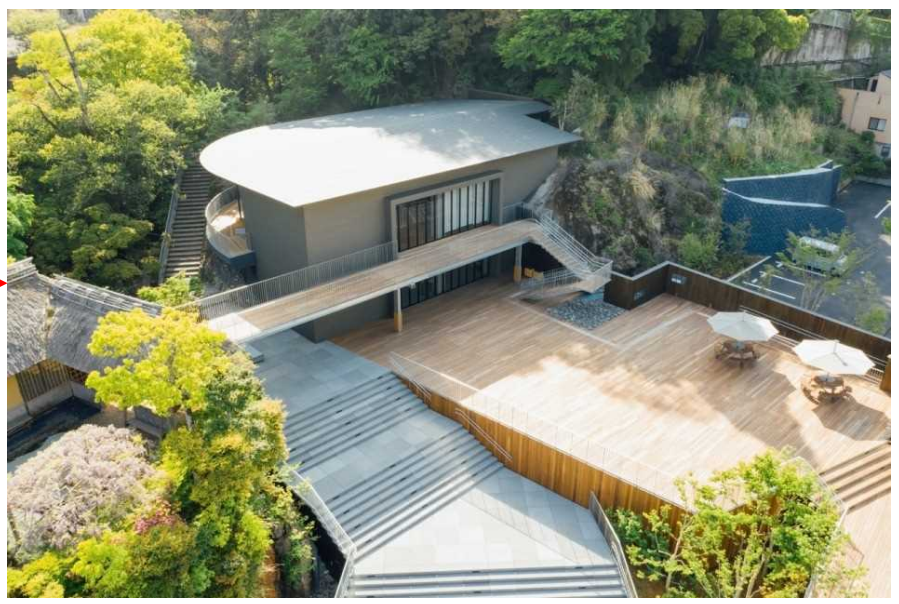
旧観光会館を減築してリノベーションされた玄関テラス
