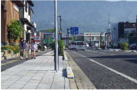
災害時の電柱倒壊等の危険回避 歩道整備(無電柱化)(佐賀県小城市)
