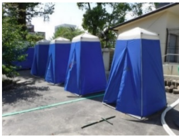
マンホールトイレ(熊本市)
