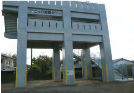
指定緊急避難場所の整備 津波避難タワー(宮崎市)
