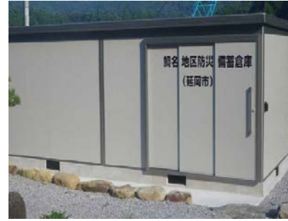
非常用食料・資機材等の備蓄 防災備蓄倉庫(宮崎県延岡市)
