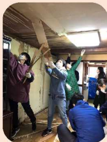
空き家解体体験
