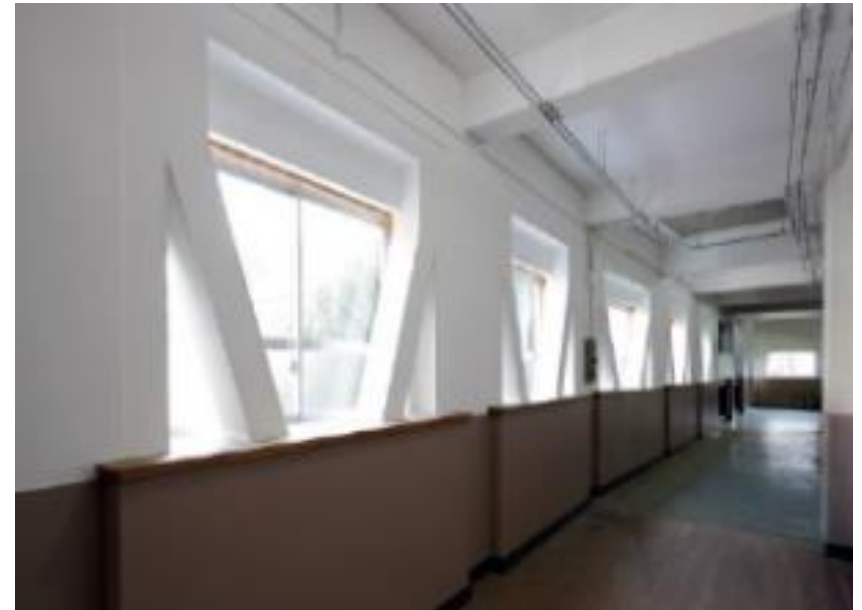
耐震補強の様子
