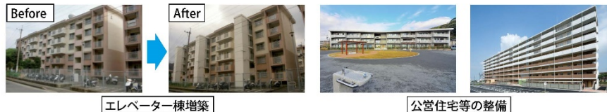
エレベーター棟増築
