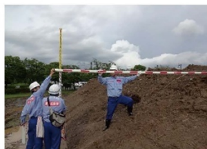
被災状況調査(堆積土砂)
