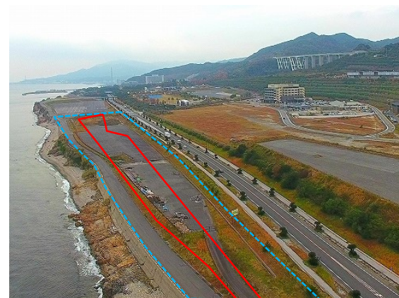
シースケープ・ラウンジ現況写真 (北側上空から南方向を撮影)
