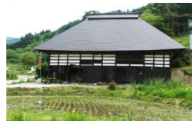
古民家を改修した体験交流施設
