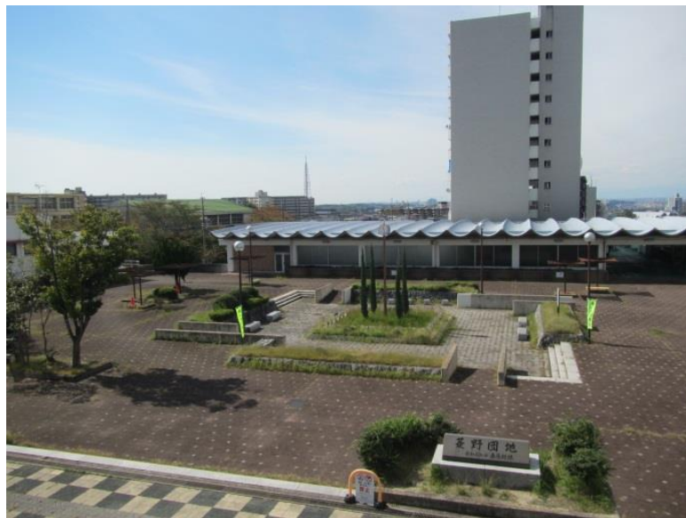
現況写真（全景）
