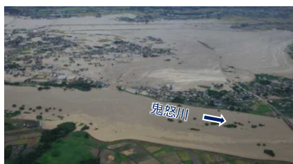
①鬼怒川の堤防決壊による浸水被害 (茨城県常総市)
