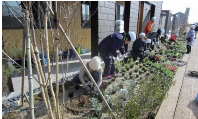
ガーデニングサークルによる施工風景
