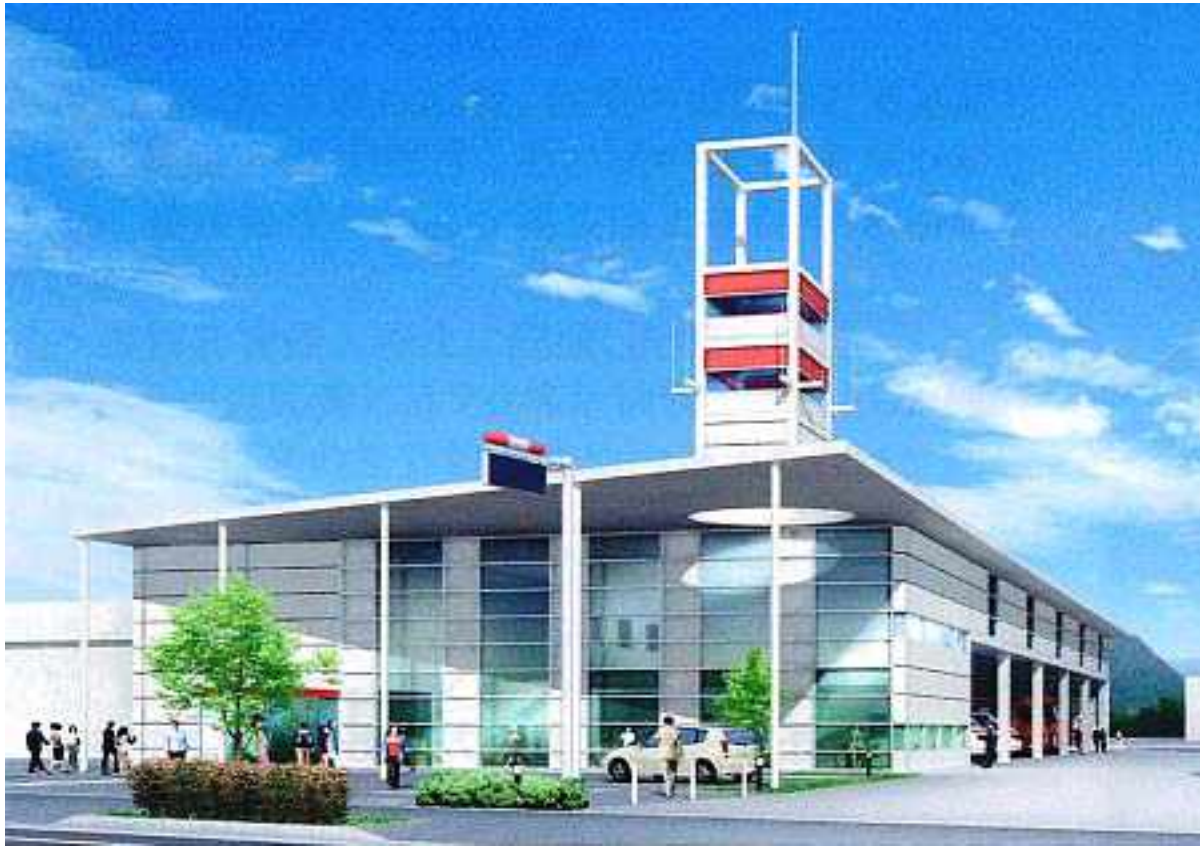
消防庁舎正面外観
