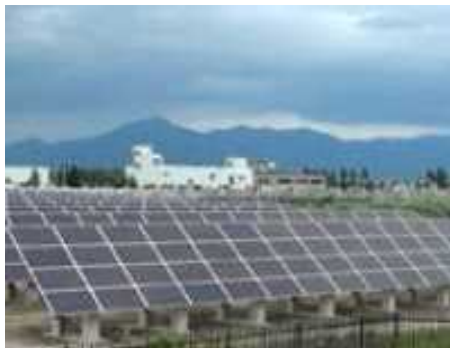
山形県 山形浄化センター
