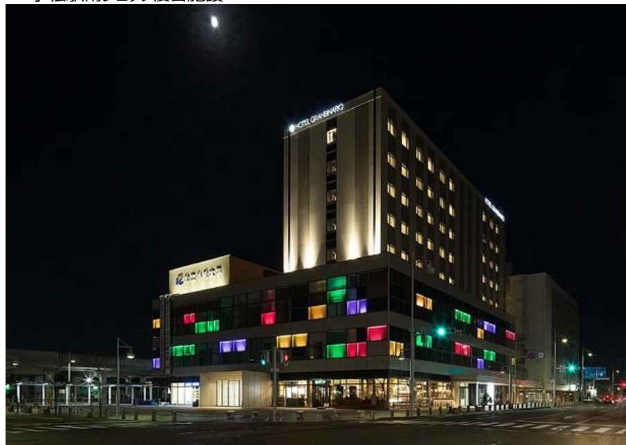
■小松駅南ブロック複合施設
