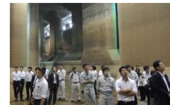
夢協 若者講習会 現場見学会 (H28.6.10 首都圏外郭放水路)
