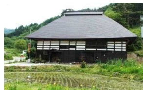
古民家を改修した体験交流施設
