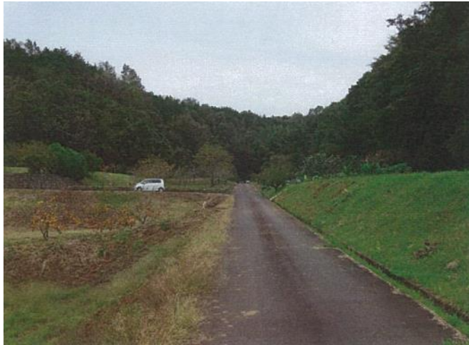
農道（南側より）
