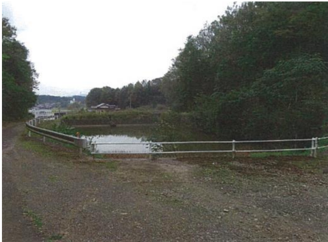
農業用ため池 対象区域南側
