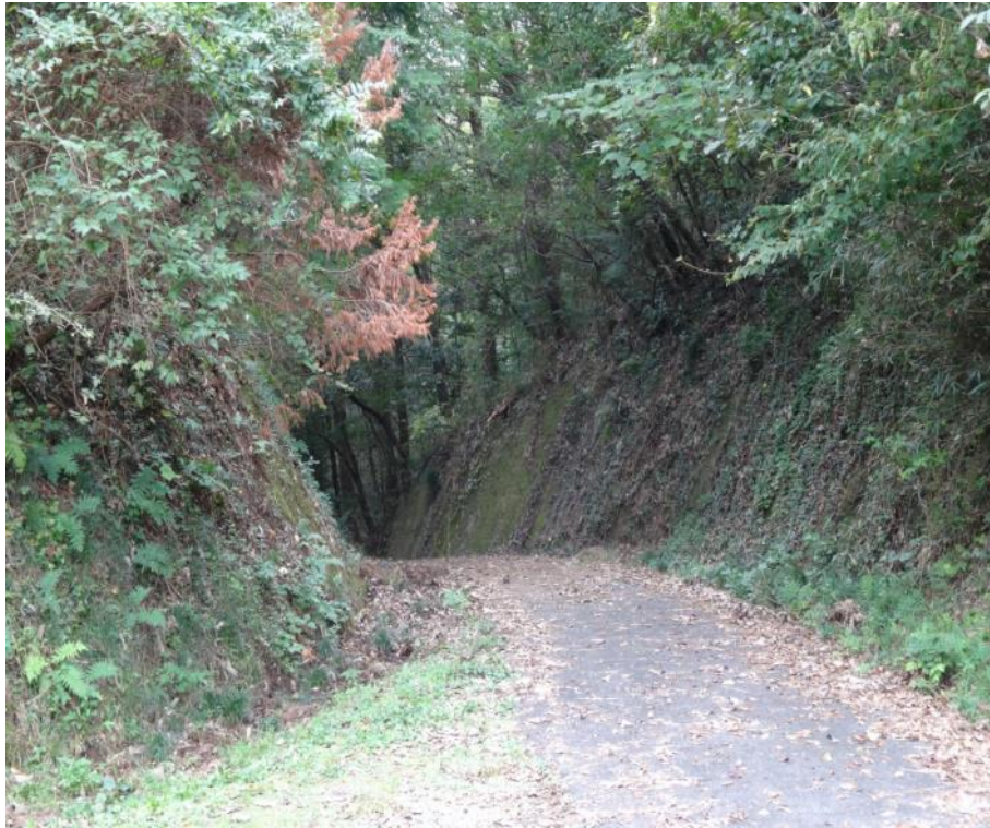
地元墓地付近の峠掘り割り
