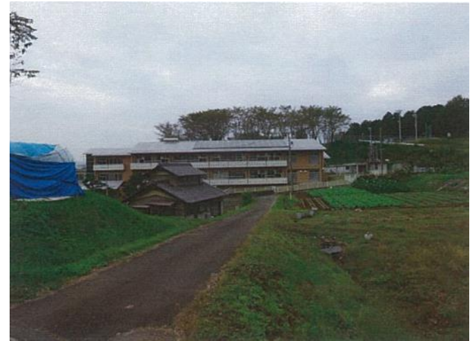
蜂屋小学校 対象地区南西
