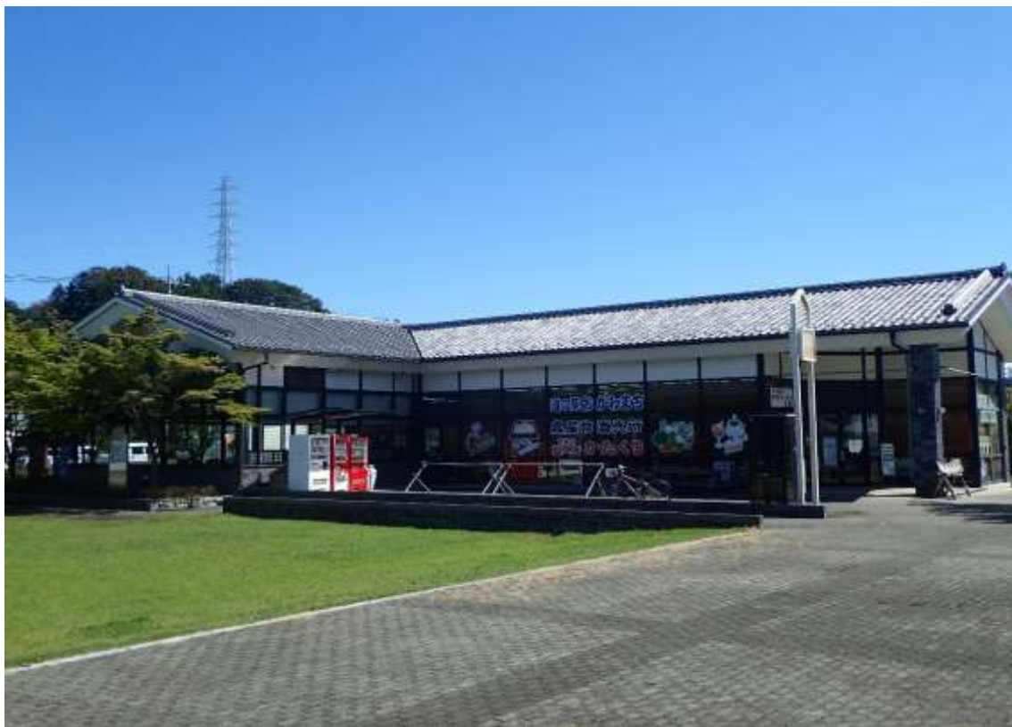
物産展示棟（道の駅販売所）
