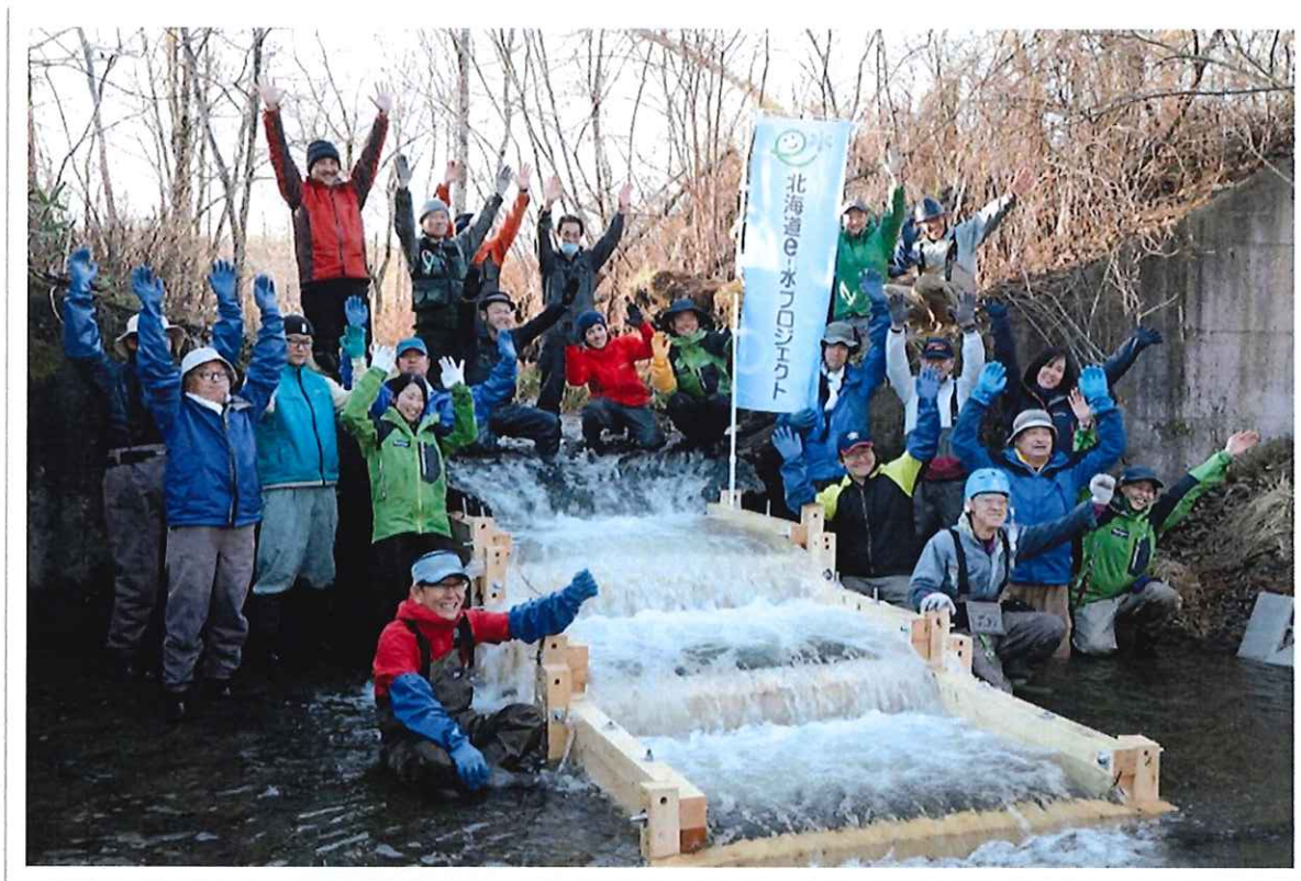
写真 11. 2019 年 流域住民、関係行政機関との協働による魚道製作
