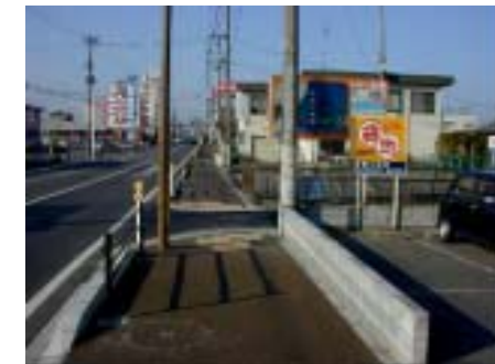
青山電線共同溝その4工事 完成写真
