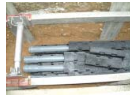
管路防護台設置状況
