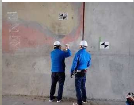
設置作業状況
