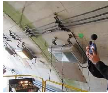
計測状況(Bトンネル)
