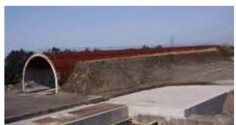
模擬トンネル全景
