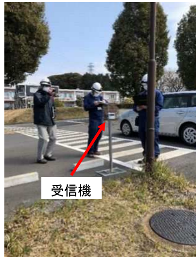
写真5b 通信試験状況 (185m地点)
