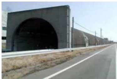
実大トンネル実験施設
