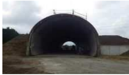
模擬トンネル全景(正面)
