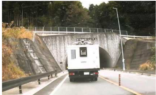
起点側坑口(北側) (下り線の計測状況※)
