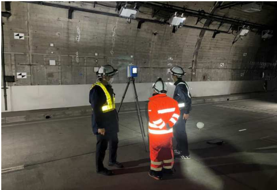
地上据置型レーザスキャナによる計測状況
