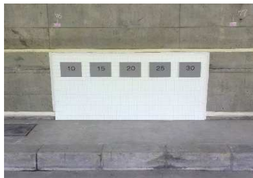
図4 模擬変状供試体 設置状況
