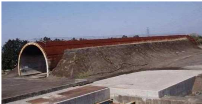
トンネル外観
