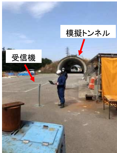
写真5a 通信試験状況
