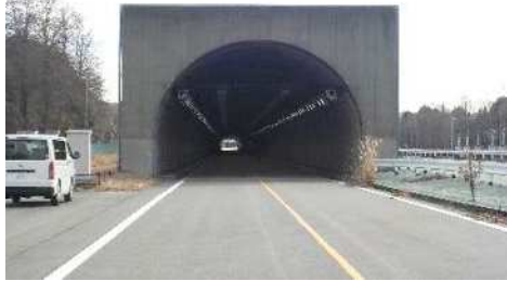
図1 対象トンネル(国総研実大トンネル)
