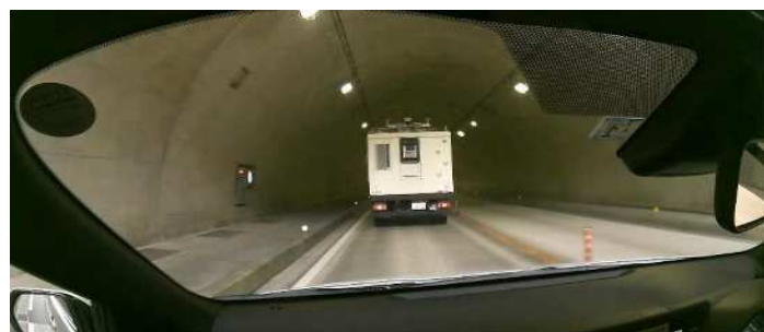
計測状況(坑内)(追尾車から撮影)時速60km/hr
