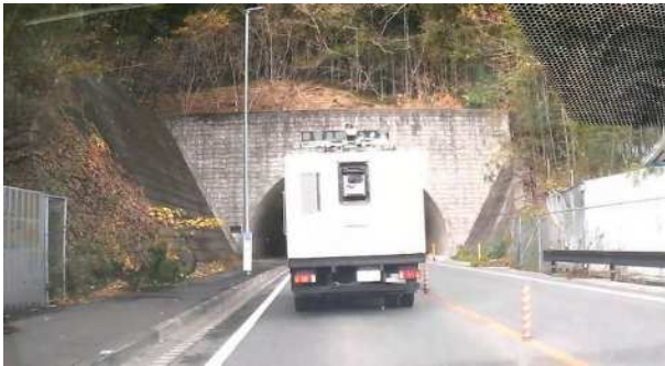
終点側坑口(南側) (上り線の計測状況)
