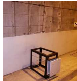
図3-3.変位測定試験体設置状況写
