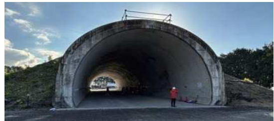
模擬トンネル全景(正面)
