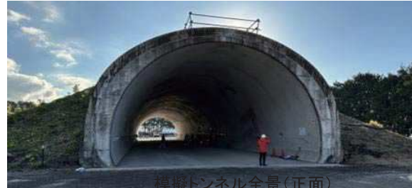
模擬トンネル全景(正面)
