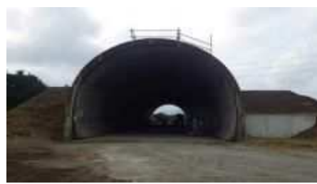
模擬トンネル全景(正面)
