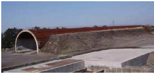
模擬トンネル全景
