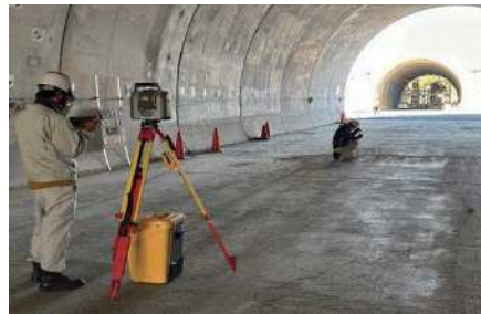
計測機器の設置位置の測量(位置決め)
