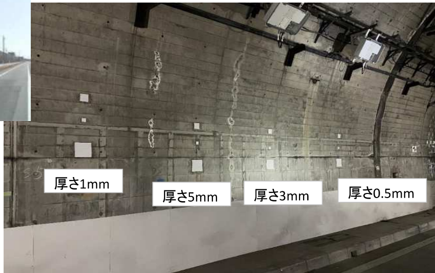
トンネル表面に「模擬うき」を設置
