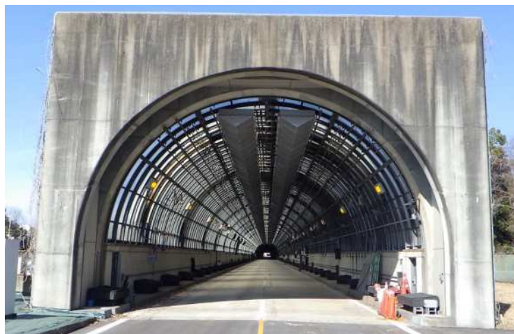
図1.トンネル坑口写真
