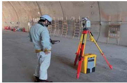
3次元点群データの計測、計測状況の監視
