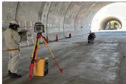
計測機器の設置位置の測量(位置決め)
