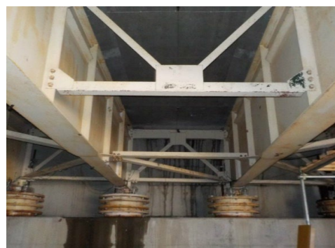
写真-1 計測箇所
