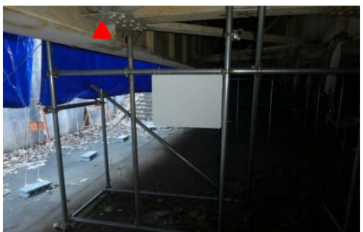
写真-2 測定対象桁および加速度測定位置
