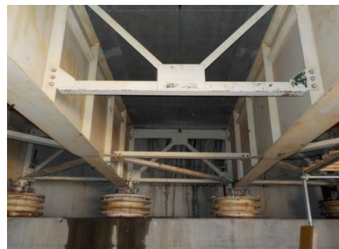
写真-1 計測箇所
