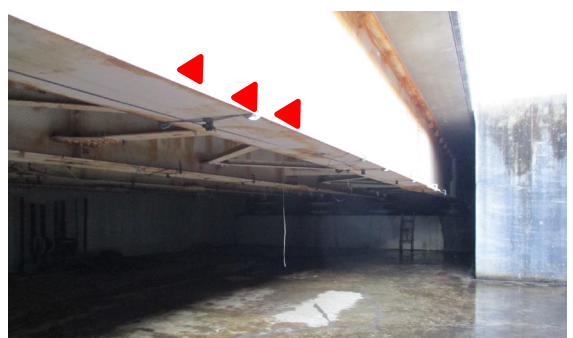
写真-2 測定対象桁およびひずみゲージ位置
