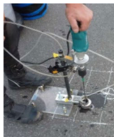
②鉄筋探査状況
