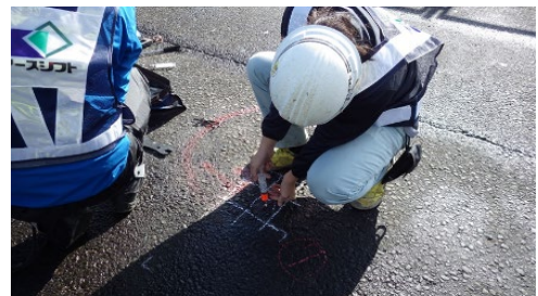
③特殊カラー樹脂の注入状況
