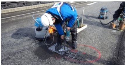
④二次削孔(φ10.5mm)
