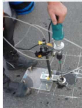
削孔状況 (舗装表面から)
