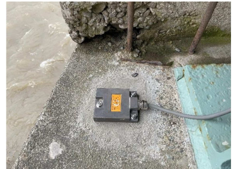
傾斜計の設置例
