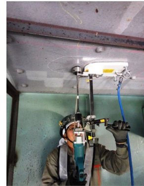
削孔状況 (床版下面から)
