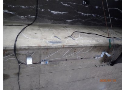
光学ストランドセンサ設置状況
