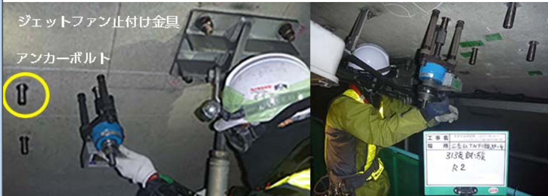
試験対象のアンカーボルトの取付物:通信機器固定/ スプリンクラー/ 照明
