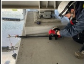
梯子が無い橋脚柱内部を橋梁より点検
