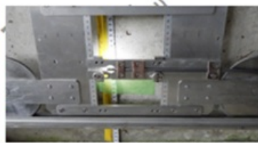
ビデオスコープ先端取付状況
