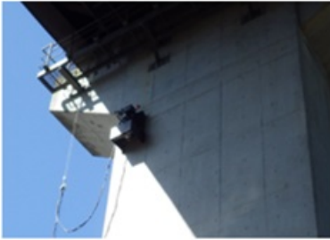
点検実施状況
