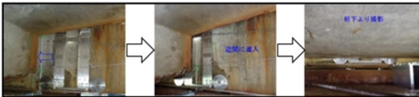
狭隙部撮影状況
