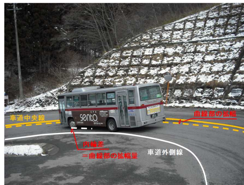
主要地方道 渋川松井田線 (群馬県)
