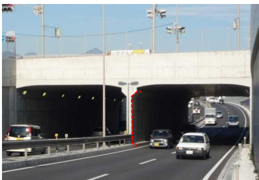
一般国道17号 高松立体(群馬県高崎市)
