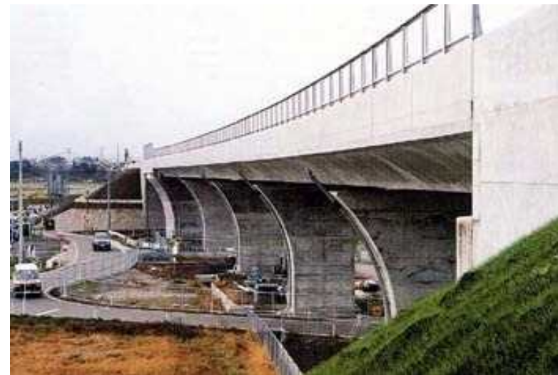
コンクリート構造(一般国道7号 秋田県大館市)
