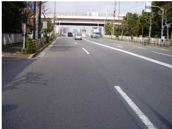
国道6号(東京都墨田区)
