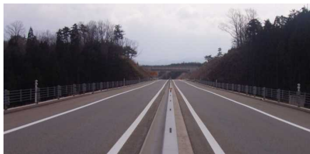
完成2車線 能越自動車道(石川県穴水町)
