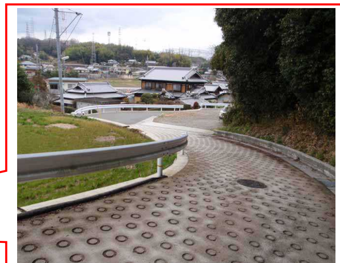
市道芝山田線（奈良県生駒市）
