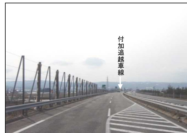
磐越自動車道
