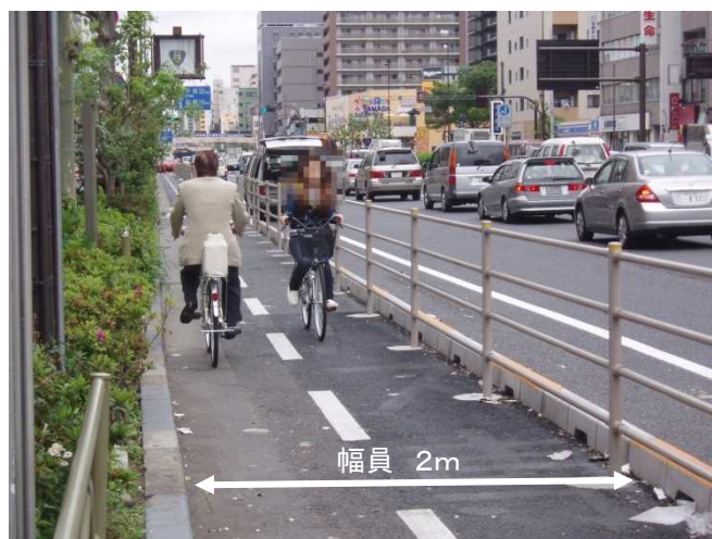
国道14号(東京都江東区)
