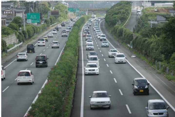
九州自動車道(福岡県)
