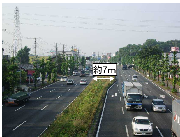
国道17号(埼玉県さいたま市)
