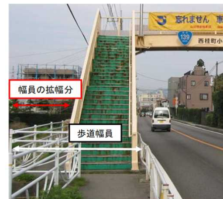
国道139号(山梨県西桂町)
