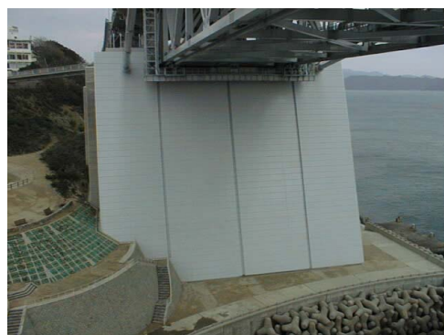
写真 - 2 表面処理による補修事例
