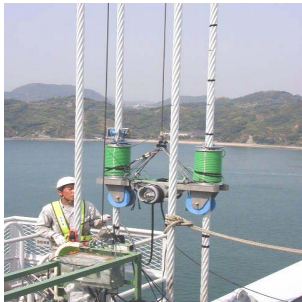
写真 - 1 非破壊検査
