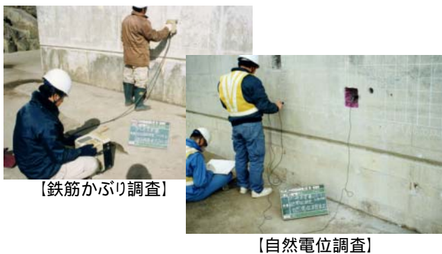
写真 - 1 コンクリート調査状況
