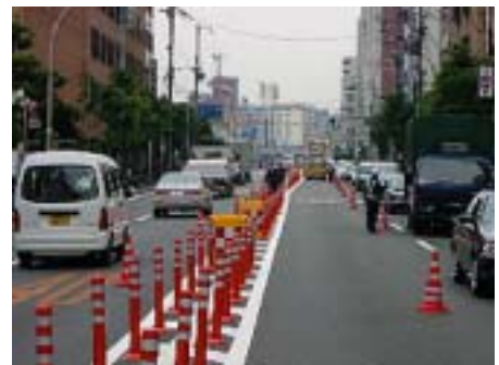
国道1号中央帯にポストコーン設置
