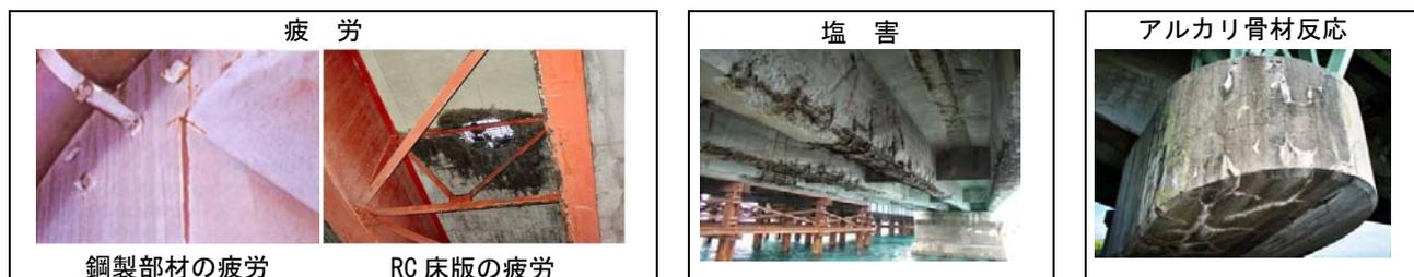
図 11-1 三大損傷の写真
