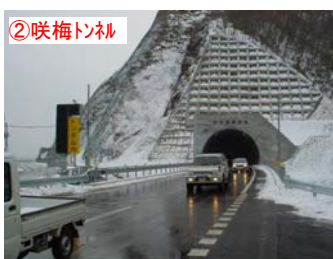
②咲梅トンネル H16 咲梅トンネル供用により 要対策箇所 3 箇所解消
