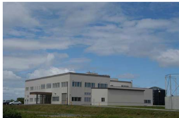
●南宗谷クリーンセンター・汚泥再生処理施設
