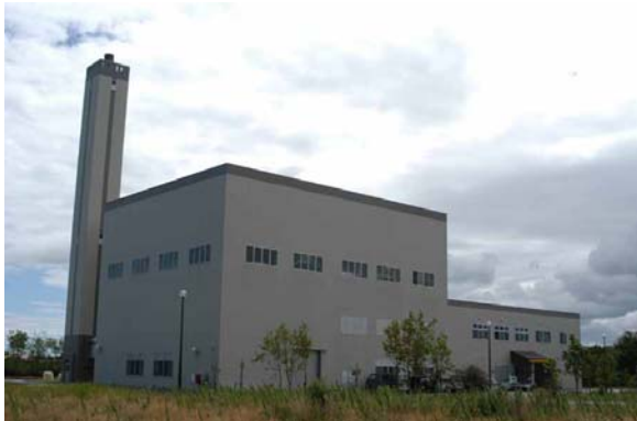
●南宗谷クリーンセンター・ごみ焼却処理施設
