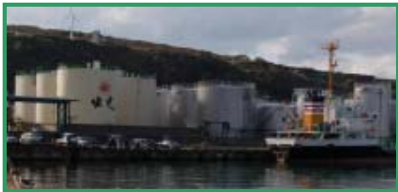
稚内港に立地する石油タンク
