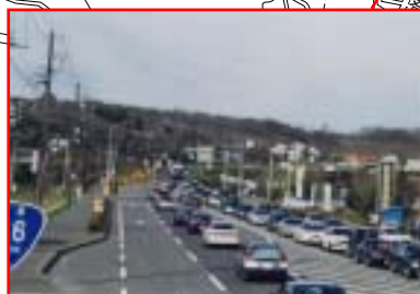
現況写真 東町交差点札幌方向 (渋滞が発生している状況)
