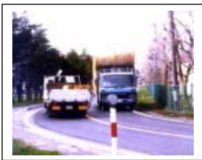
現道における狭小区間
