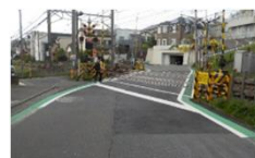
踏切道内の車道外側線
