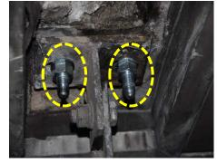
不具合の内容: アンカーボルトの腐食(笹子トンネル(下り線))
