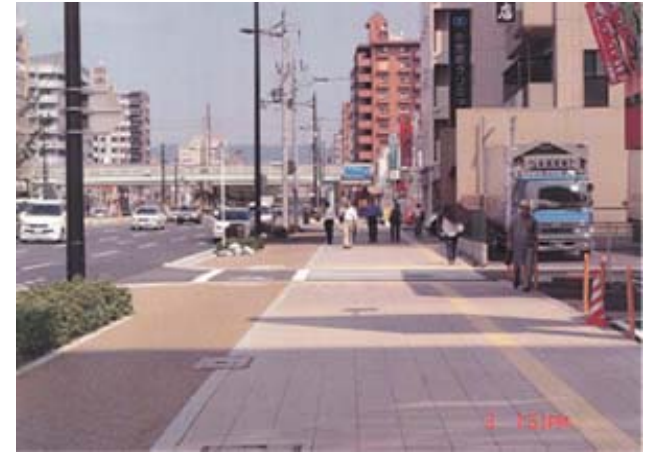
国道9号五条大宮拡幅工事 (出典: 京都国道事務所HP)
