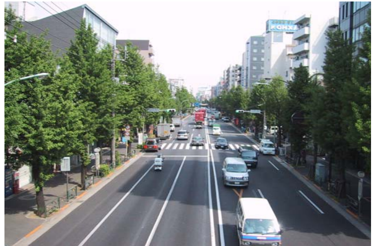
延焼遮断機能を有する道路 (出典: 東京都都市整備局HP)
