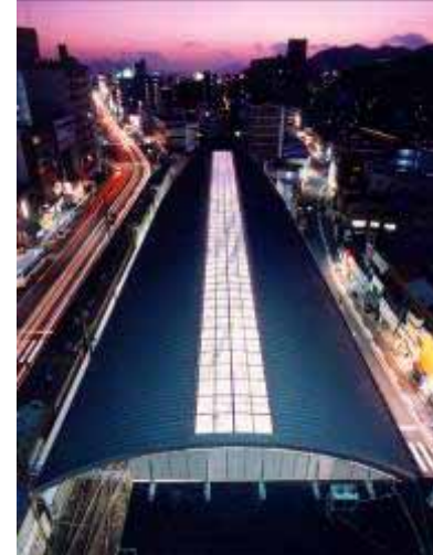
地域のランドマークとなったドーム型屋根
