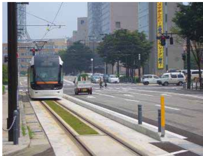
車道敷設部分
